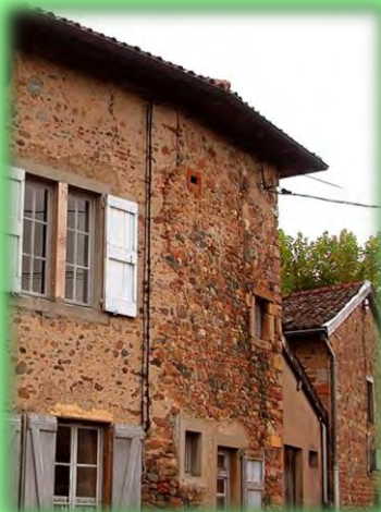
Trias et socle dans le mur (E)
