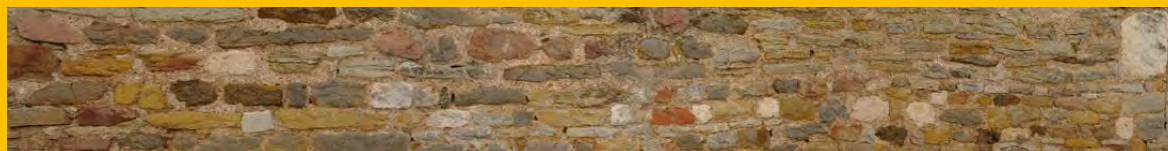
Mur extérieur de la nef, côté Nord
